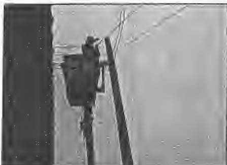
ซ่อมแซมระบบประปาภายในตำบลโดยพนักงานของ อบต.จากเงินข้อบัญญัติฯ ปี๕๙
