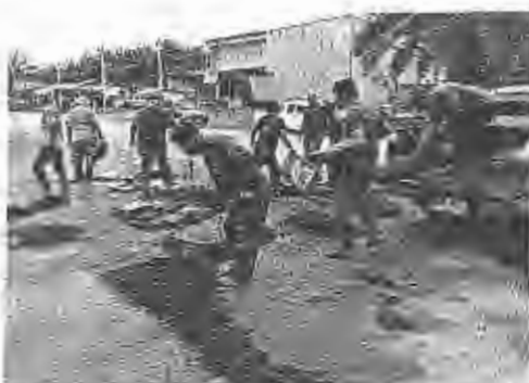
ซ่อมแซมถนนลาดยางโดยอบต.จัดซื้อยางมะคอย จากเงินข้อบัญญัติฯ ปี๕๙
