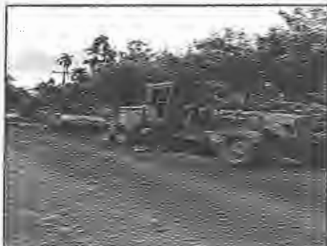
ซ่อมแซมถนนลูกรังภายในตำบลโดยพนักงานและเครื่องจักรกลของ อบต.จากเงินข้อบัญญัติฯ ปี๕๙
