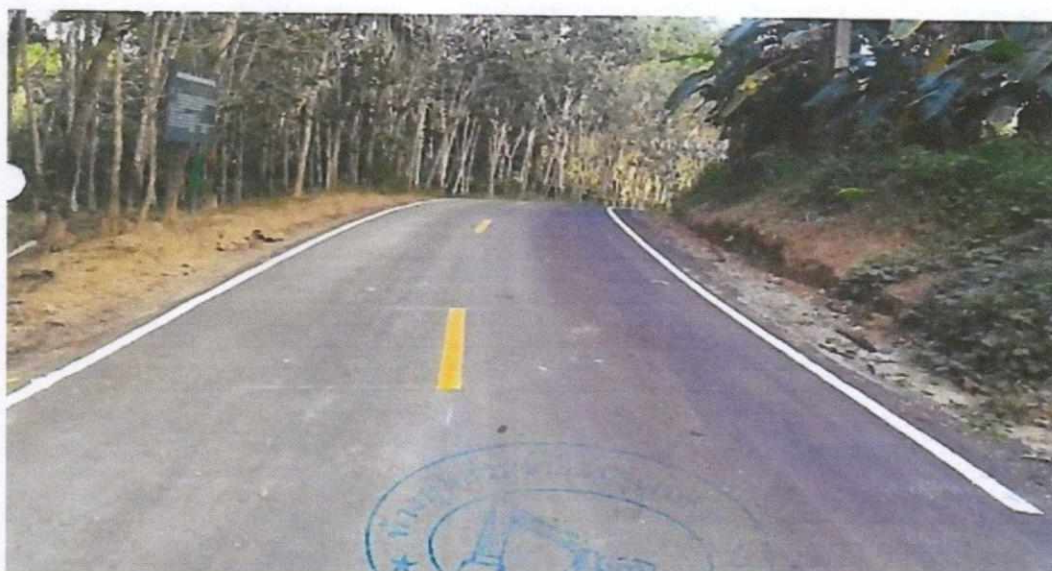
ก่อสร้างถนนลาดยางเคปซีล สายชังกล้วย หมู่ที่ ๔ งบประมาณ ๙๘๖,๐๐๐.-บาท จากข้อบัญญัติฯ ปี ๒๕๖๐
