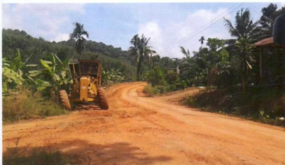
ซ่อมแซมถนนลูกรังภายในตำบลโดยพนักงานและเครื่องจักรกลของ อบต. จากเงินข้อบัญญัติฯ ปี ๒๕๖๐
