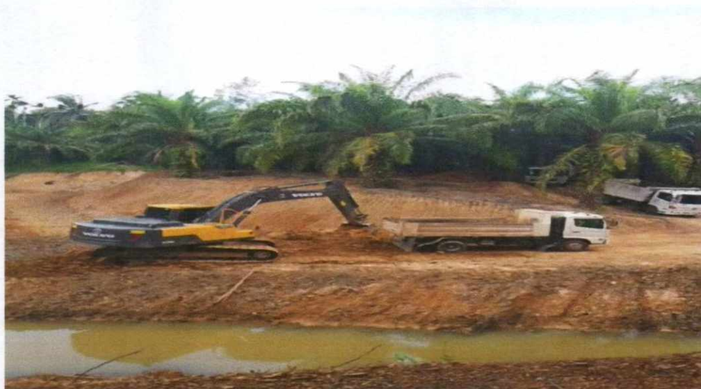
ขุดลอกสระน้ำ หมู่ที่ ๒ และ หมู่ที่ ๕ โดยพนักงานของ อบต.และเครื่องจักร จากเงินข้อบัญญัติฯ ปี ๒๕๖๐
