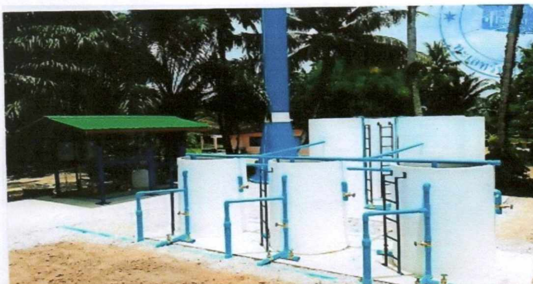
ก่อสร้างระบบประปาหมู่บ้าน บ้านนายาว หมู่ที่ ๒ งบประมาณ ๑,๔๑๗,๓๘๙. -บาท จากข้อบัญญัติฯ ปี ๒๕๖๐
