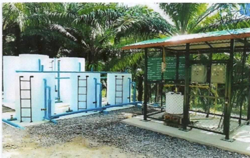
ปรับปรุงระบบประปา หมู่ที่ ๑๓ งบประมาณ ๕๙๕,๓๐๐.- บาท จากข้อบัญญัติฯ ปี ๒๕๖๐
