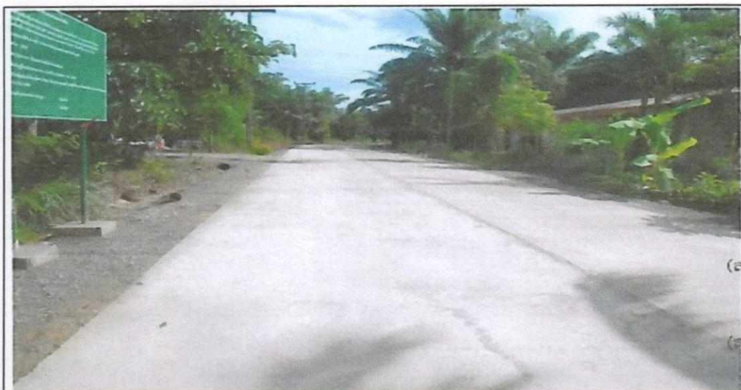
ก่อสร้างถนน คสล.สายประชาพิพัฒน์ หมู่ที่ ๓ งบประมาณ ๙๙๗,๐๐๐.- บาท จากข้อบัญญัติฯ ปี ๒๕๖๐
