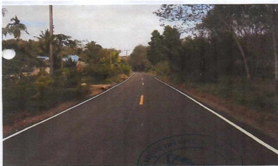
ก่อสร้างลาดยางเคปซีล สายสมานมิตร หมู่ที่ ๑๒ งบประมาณ ๙๙๕,๐๐๐.- บาท จากจ่ายขาดเงินสะสม ปี ๒๕๖๐
