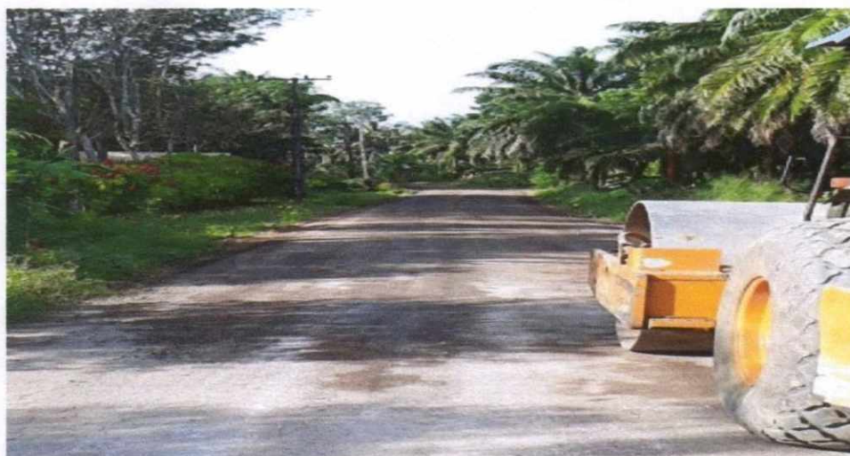
ซ่อมแซมถนนลูกรังโดยใช้กากมิกซ์ (วัสดุใส) หมู่ที่ ๓ หมู่ที่ ๔ หมู่ที่ ๕ หมู่ที่ ๘ หมู่ที่ ๑๔ จากเงินข้อบัญญัติฯ ปี ๒๕๖๐
