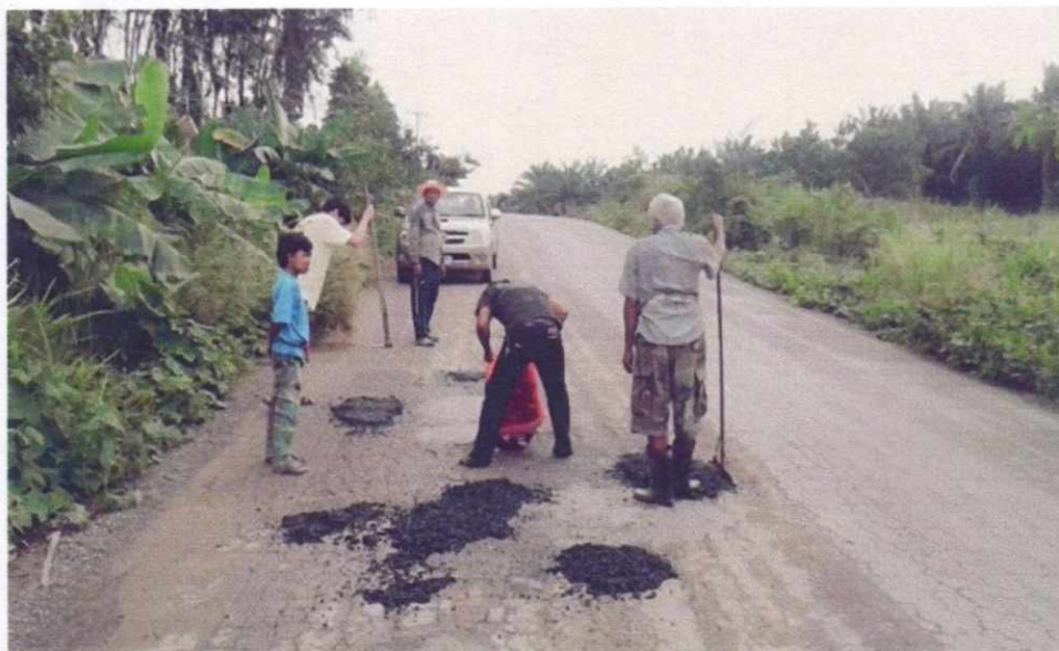
ซ่อมแซมถนนลาดยางโดย อบต.จัดซื้อยางมะตอยให้ จากเงินข้อบัญญัติฯ ปี ๒๕๖๐
