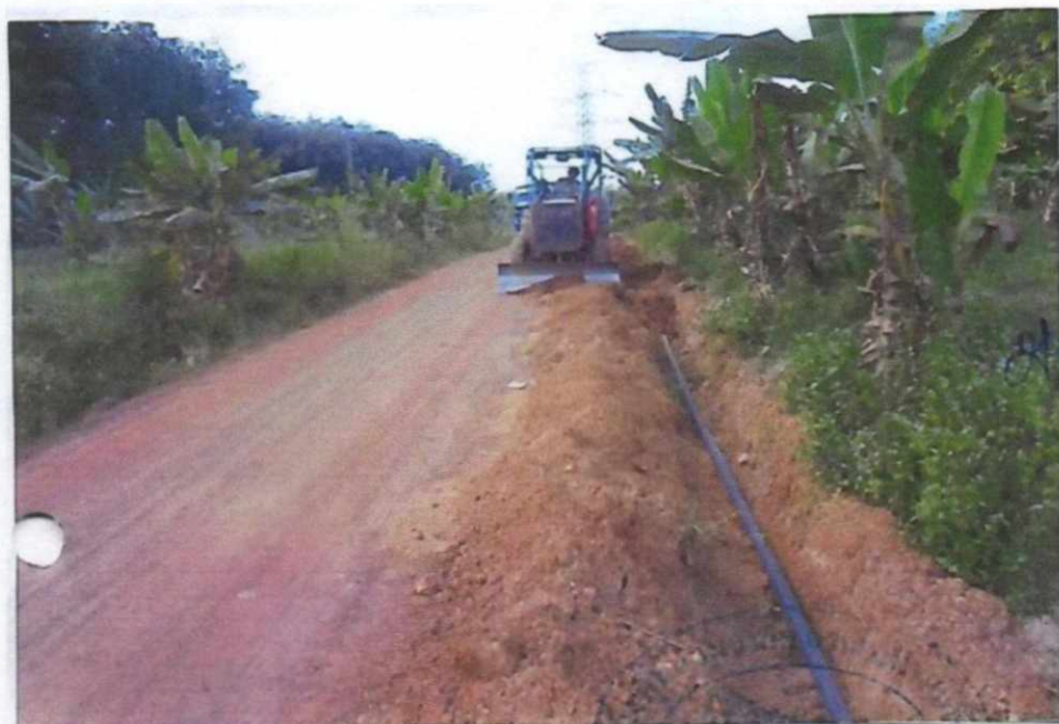
ขยายเขตท่อจ่ายน้ำประปา ม.๑๒ งบประมาณ ๕๕๔,๐๐๐.- บาท จ่ายจากข้อบัญญัติ ปี ๒๕๖๐
