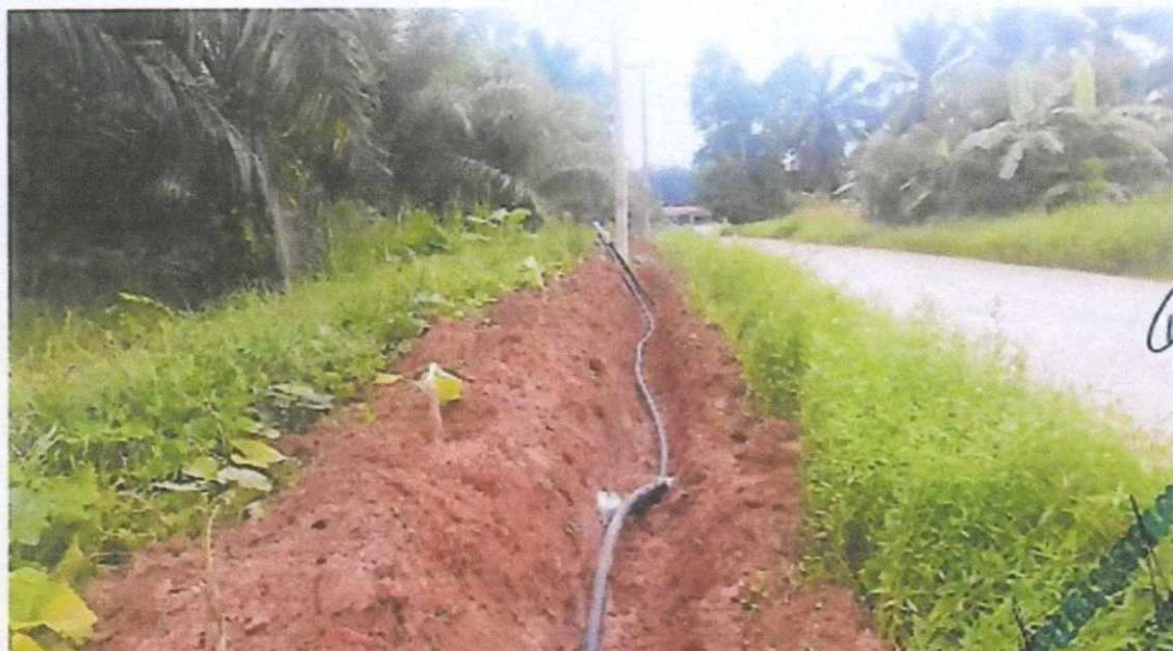
ปรับปรุงระบบประปาหมู่บ้าน บ้านตาหงษ์ หมู่ที่ ๕ งบประมาณ ๕๓๐,๐๐๐.- บาท จากข้อบัญญัติฯ ปี ๒๕๖๐
