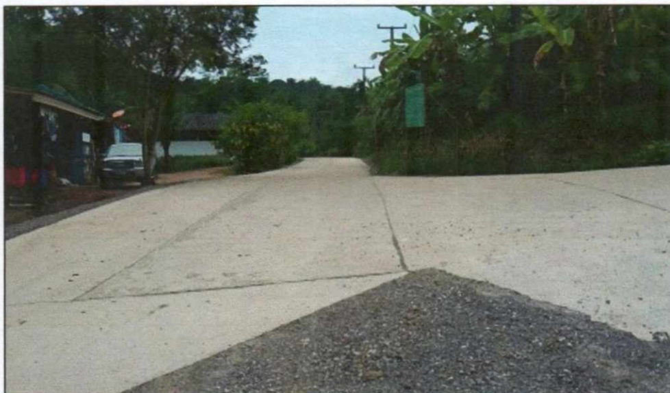
ก่อสร้างถนน คสล.สายท่าทองพัฒนา หมู่ที่ ๑๐ งบประมาณ ๔๘๔,๐๐๐.- บาท จากจ่ายขาดเงินสะสม ปี ๒๕๖๐
