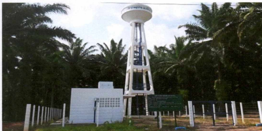
ก่อสร้างระบบประปาผิวดินขนาดกลาง บ้านนายาว หมู่ที่ ๒ งบประมาณ ๒,๒๘๒,๒๘๙. -บาท จากเงินอุดหนุนเฉพาะกิจ ปี ๒๕๖๐
