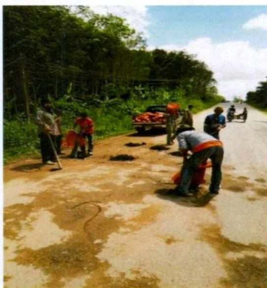
ซ่อมแซมถนนลาดยางโดยอบต.จัดซื้อยางมะตอยให้ จากเงินข้อบัญญัติฯ ปี ๖๑
