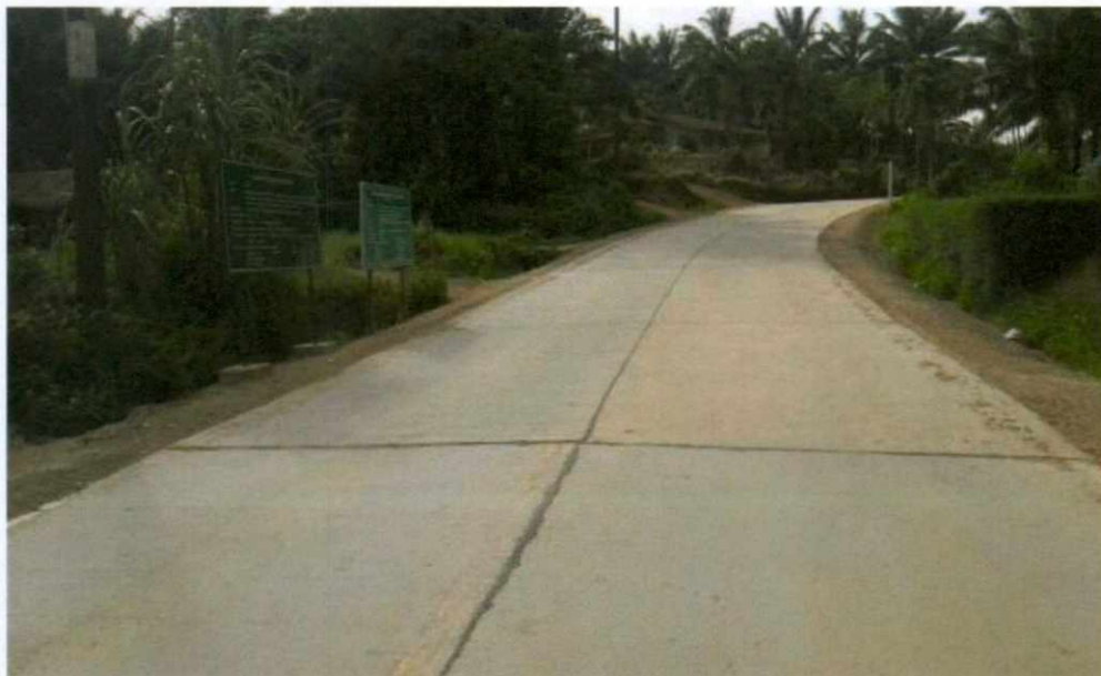
ก่อสร้างถนน คสล.สายปากด่าน-ยายหม่น ม.๑๓ งบประมาณ ๓๒๓,๐๐๐.- บาท จ่ายจากเงินสะสม ปี ๖๑
