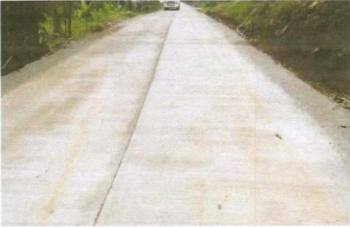
ก่อสร้างถนน คสล.สายโป่งบอน-ธรรมเจริญ ม.๙ งบประมาณ ๔๙๙,๐๐๐.- บาท จ่ายจากข้อบัญญัติฯ ปี ๖๑
