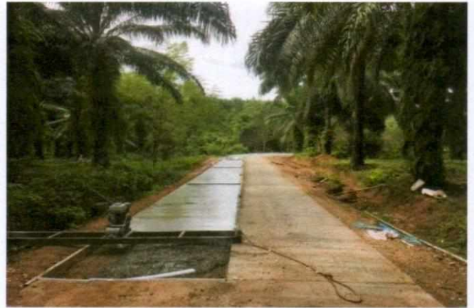
ก่อสร้างถนน คสล. สายสมานมิตร ซอย ๒ ม.๑๒ งบประมาณ ๔๙๙,๐๐๐.- บาท จ่ายจากเงินสะสม ปี ๖๑
