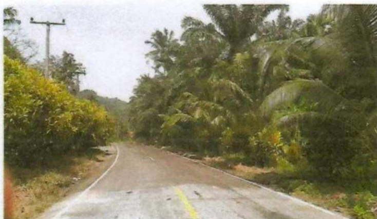
ก่อสร้างลาดยางเคปซีล สายเศรษฐกิจดำรง ม.๗ งบประมาณ ๔๙๘,๐๐๐.- บาท จากจ่ายซื้อบุญฤดีฯ ปี ๖๑
