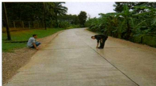
ก่อสร้างถนน คสล.สายเฉลิมราษฎร์ ม. ๔ งบประมาณ ๔๙๙,๐๐๐.- บาท จ่ายจากเงินสะสม ปี ๒๕๖๑
