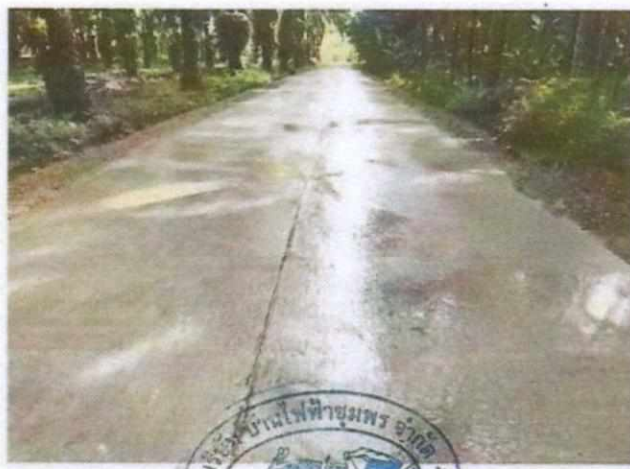
ก่อสร้างถนน คสล.สายบึงลัด ซ.๓ ม.๖ งบประมาณ ๔๙๙,๐๐๐.- บาท จ่ายจากเงินสะสม ปี ๒๕๖๑
