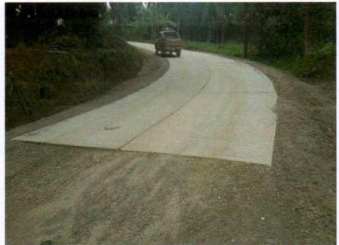
ก่อสร้างถนน คสล.สายสามัคคีชัย ม.๑๓ งบประมาณ ๔๙๘,๐๐๐.- บาท จ่ายจากเงินสะสม ปี ๖๑
