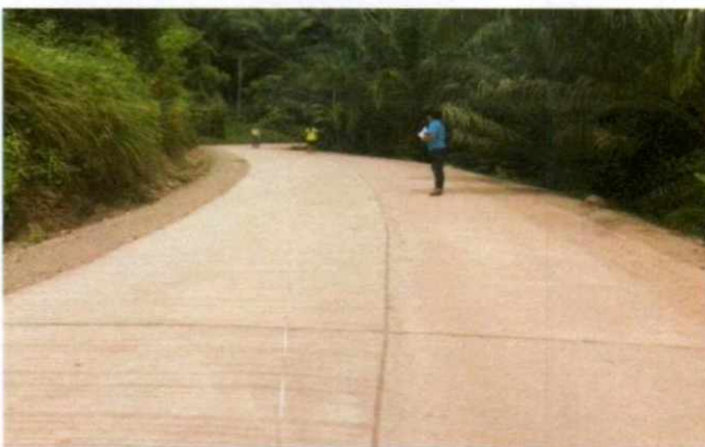
ก่อสร้างถนน คสล.สายธรรมเจริญ-คลองใหญ่บน ม.๑๐ งบประมาณ ๔๙๙,๐๐๐.- บาท จ่ายจากเงินสะสม ปี ๖๑
