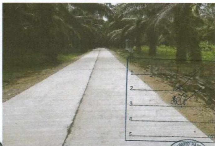
ก่อสร้างถนน คสล.สายราษฎร์พัฒนา ม. ๓ งบประมาณ ๗๒๔,๐๐๐.- บาท จ่ายจากข้อบัญญัติฯ ปี ๒๕๖๑
