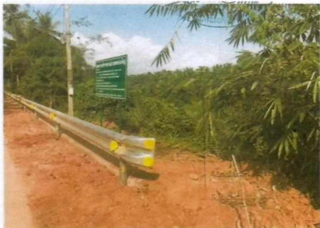
ก่อสร้างกำแพงกันดินพังทลายสายหัวโปร่ง-ยายไท ม.๑๔ งบประมาณ ๑๙๒,๐๐๐.- บาท จ่ายจากข้อบัญญัติฯ ปี ๖๑
