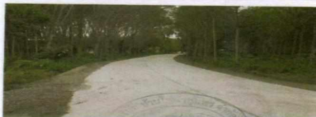
ก่อสร้างถนน คสล.สายหัวโปร่ง-ตันโดน ม.๑๔ งบประมาณ ๔๙๙,๐๐๐.- บาท จ่ายจากเงินสะสม ปี ๖๑
