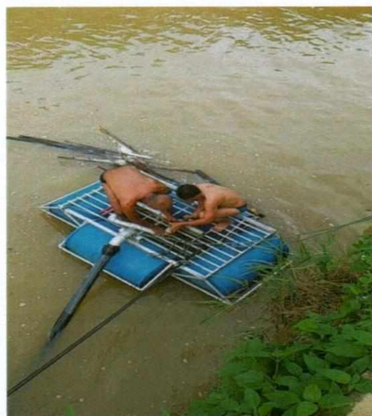
ซ่อมแซมระบบประปาภายในตำบลโดยพนักงานของ อบต. จากเงินข้อบัญญัติฯ ปี ๖๑
