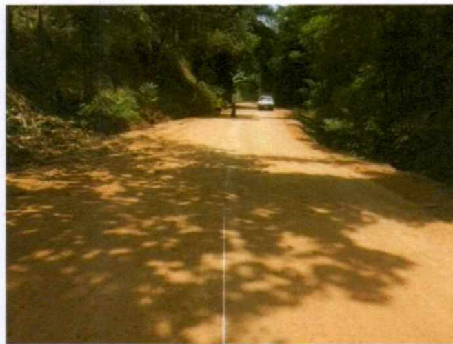
ก่อสร้างถนน คสล.สายโป่งบอน-ธรรมเจริญ ม.๙ งบประมาณ ๔๙๙,๐๐๐ บาท จ่ายจากเงินสะสม ปี ๖๑
