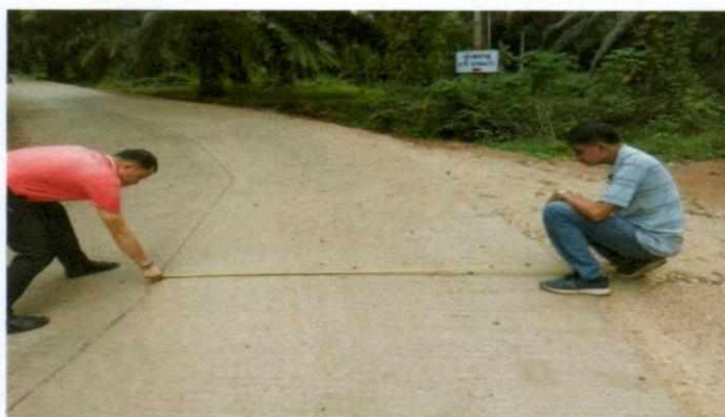
ก่อสร้างถนน คสล.สายบึงลัด ซ.๕ ม.๖ งบประมาณ ๔๙๘,๐๐๐.- บาท จ่ายจากเงินสะสม ปี ๒๕๖๑
