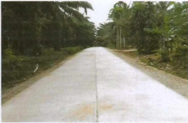
ก่อสร้างถนน คสล. สายสมานมิตร ซอย ๒ ม.๑๒ งบประมาณ ๔๙๙,๐๐๐.- บาท จ่ายจากข้อบัญญัติ ฯ ปี ๖๑
