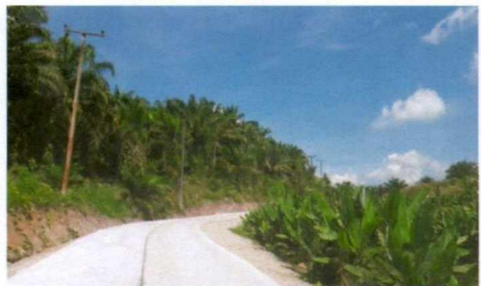
ก่อสร้างถนน คสล.สายธรรมเจริญ-คลองใหญ่บน ม.๑๐ งบประมาณ ๗๔๕,๐๐๐.- บาท จ่ายจากข้อบัญญัติฯ ปี ๖๑ (อยู่ระหว่างดำเนินการ)
