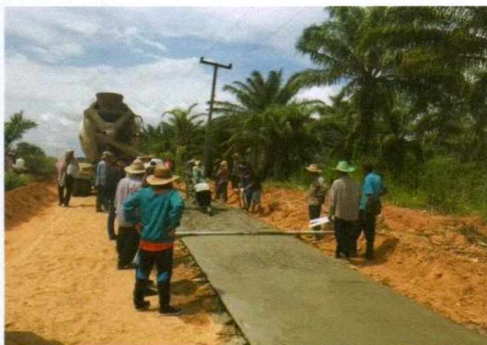
ก่อสร้างถนน คสล.สายสุขเจริญ ม.๑๑ งบประมาณ ๘๘,๐๐๐.- บาท จ่ายจากข้อบัญญัติฯ ปี ๖๑ (โดยใช้แรงงานจากชาวบ้าน ม.๑๑)
