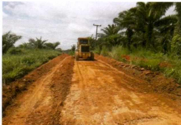
ซ่อมแซมถนนลูกรังภายในตำบลโดยพนักงานและเครื่องจักรกล ของ อบต. จากเงินข้อบัญญัติฯ ปี๖๑
