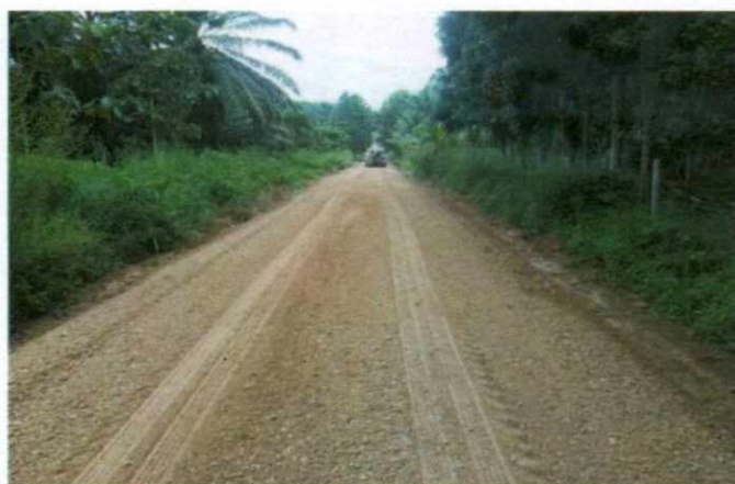
ปรับปรุงถนนลูกรังเป็นถนนหินคลุก ถนนสายซอย ๑ และซอยพิเศษ ๓ ม.๘ งบประมาณ ๔๙๙,๐๐๐.- จ่ายจากเงินสะสม ปี ๖๑
