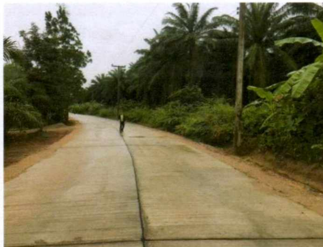
ก่อสร้างถนน คสล.สายประชาธิปไตย ม. ๓ งบประมาณ ๔๙๖,๐๐๐.- บาท จ่ายจากเงินสะสม ปี ๒๕๖๑
