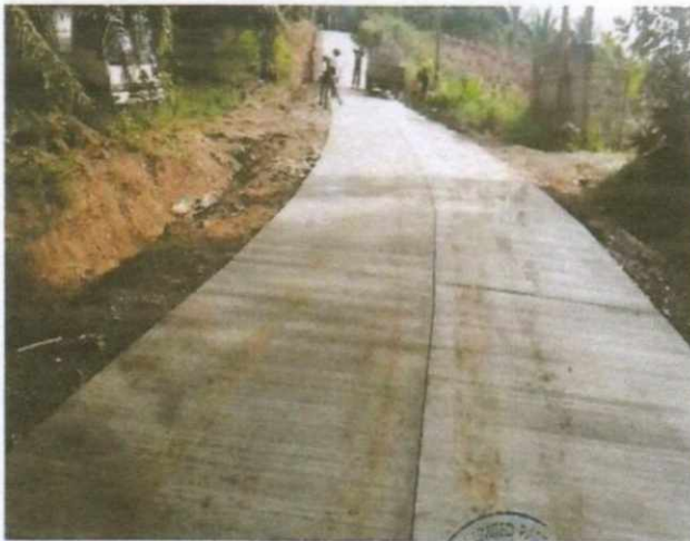
ก่อสร้างถนน คสล.สายสุขสมบูรณ์ ม.๑๓ งบประมาณ ๔๙๙,๐๐๐.- บาท จ่ายจากข้อบัญญัติฯ ปี ๖๑
