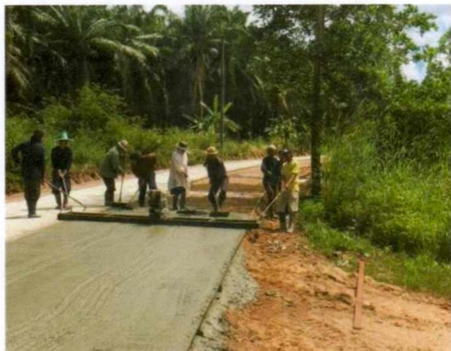
ก่อสร้างถนน คสล.สายราษฎร์พัฒนา ม. ๓ งบประมาณ ๗๒๔,๐๐๐.- บาท จ่ายจากข้อบัญญัติฯ ปี ๒๕๖๑
