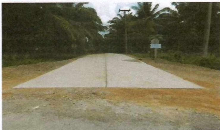
ก่อสร้างถนน คสล.สายสังธรรม ม.๑๑ งบประมาณ ๔๒๕,๐๐๐.- บาท จ่ายจากข้อบัญญัติฯ ปี ๖๑
