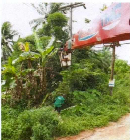
ซ่อมแซมไฟฟ้าสาธารณะภายในตำบลโดยพนักงาน ของ อบต. จากเงินข้อบัญญัติฯ ปี๖๑
