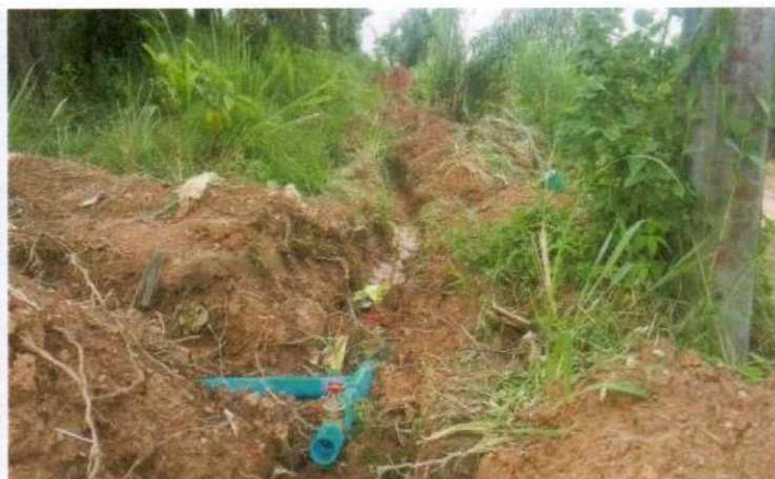
ขยายเขตท่อจ่ายน้ำประปาหมู่บ้าน บ้านโป่งบอน ม.๑๑ งบประมาณ ๔๙๙,๐๐๐.- บาท จ่ายจากเงินสะสม ปี ๖๑
