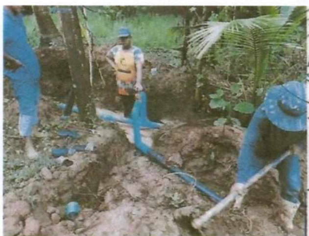
ขยายเขตท่อจ่ายน้ำประปาหมู่บ้าน ม.๑๔ งบประมาณ ๔๙๐,๐๐๐.- บาท จ่ายจากเงินสะสม ปี ๖๑
