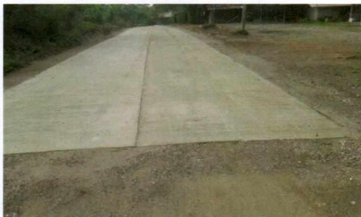
ก่อสร้างถนน คสล.สายนิคม ซ.๑ ม. ๕ งบประมาณ ๕๙๕,๐๐๐.- บาท จ่ายจากข้อบัญญัติฯ ปี ๒๕๖๑
