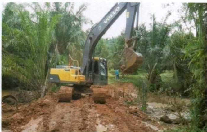
ขุดลอกถนนซ่อมแซมถนนชำรุด โดยพนักงานของ อบต. และเครื่องจักร จากเงินข้อบัญญัติฯ ปี๖๑
